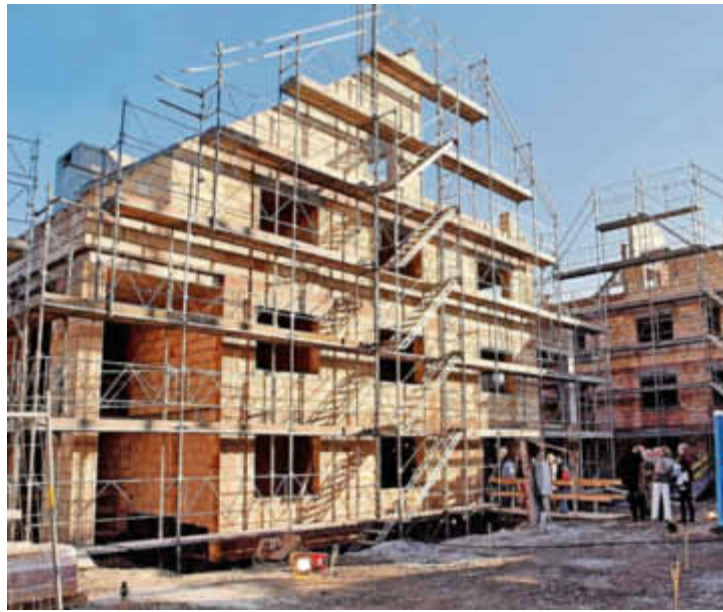
Aufrichte: siebeneinhalb Monate nach dem Spatenstich. Bild: e
